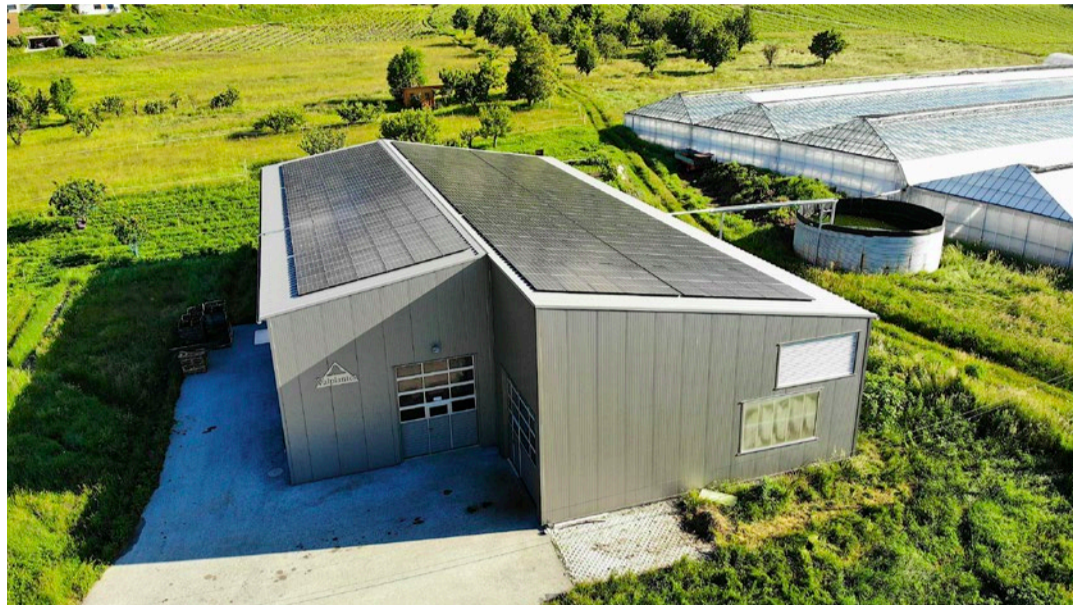
Des panneaux solaires recouvrent le toit du bâtiment de production de Valplantes, sur le site de Grimisuat (VS).
