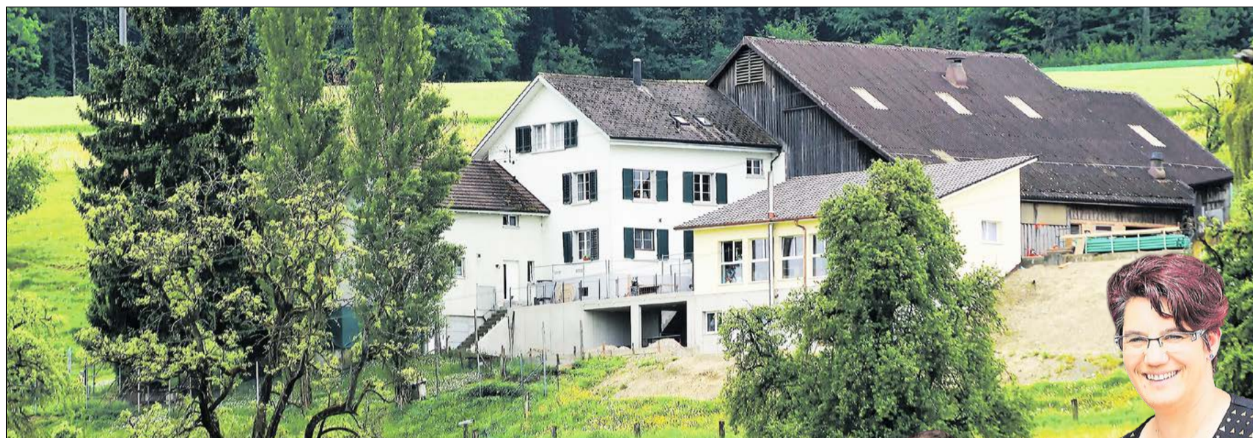
Der Abriss eines alten Gebäudes brachte Platz: Im gelben Neubau sind die Räume der Kinderkrippe und die Holzschnitzelheizung untergebracht.
